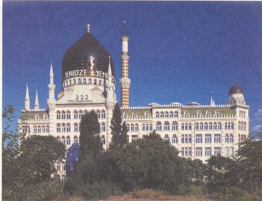
Kuppelbau für Tanzbären: Die denkmalgeschützte Tabakfabrik Yenidze beherbergt heute unter anderem eine Diskothek. Foto DWT/Dittrich
